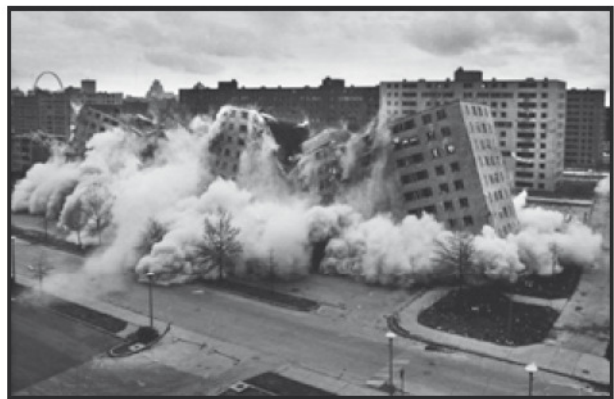
Abb. 4: Sprengung eines Pruitt-Igoe-Wohngebäudes Quelle: citylab.com
