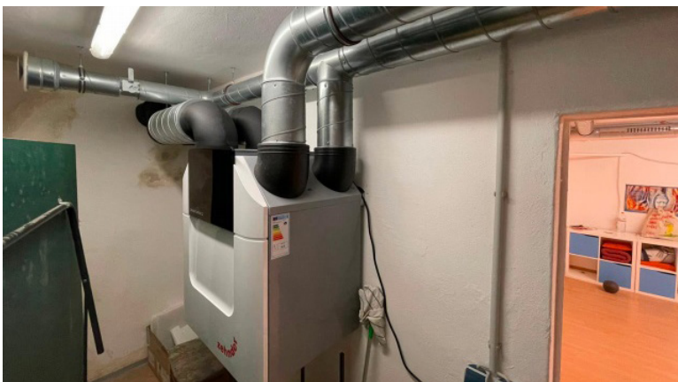
Abb. 2: Kinderheim Friedensberg (Sportraum) kontrollierte Wohnraumlüftung (KWL-Gerät) mit 300\text{m}^3/\text{h} Volumenstrom (Quelle: Stadt Jena)
