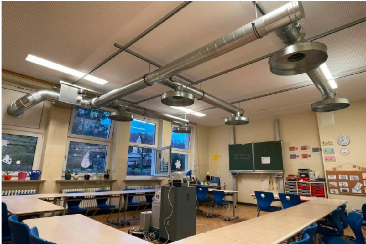
Abb. 1: Südschule (Raum 00_18) Provisorium nach Modell Max-Planck-Lüftungsanlage (Quelle: Stadt Jena KIJ)
